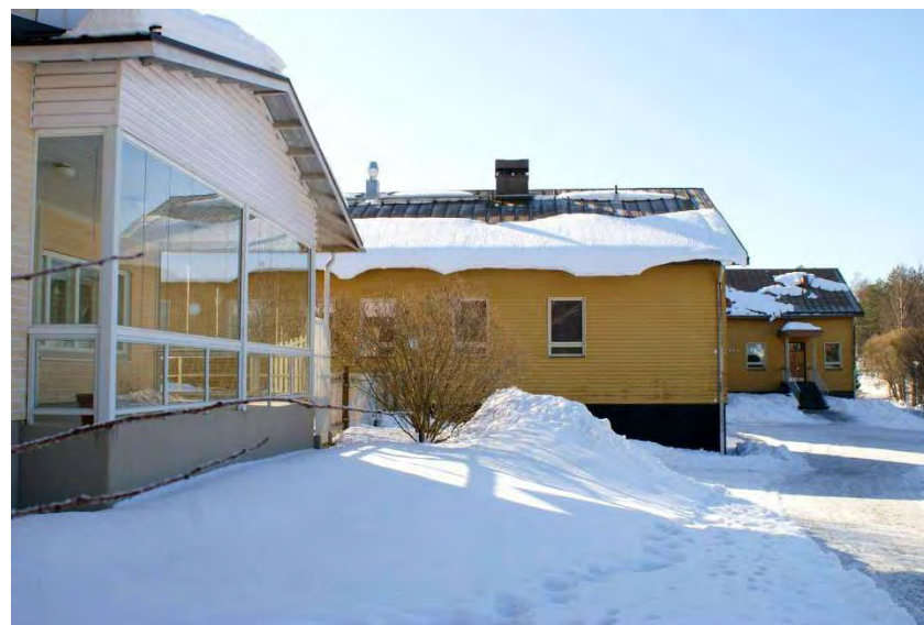
Kuva: C:n parvekepääty, B:n takafasadia ja A:n siipirakennusta.
