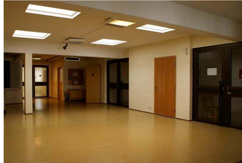
Kuva: Avarissa tiloissa, kuten aulassa, tulee näkyvillä rakennuksen pilaripalkkirunko. Katossa näkyvät valokuilut. Vihertävä lattia, tammiviilupintaiset sisäovet tehosteväreillä maalatuin vuorilistoin.
