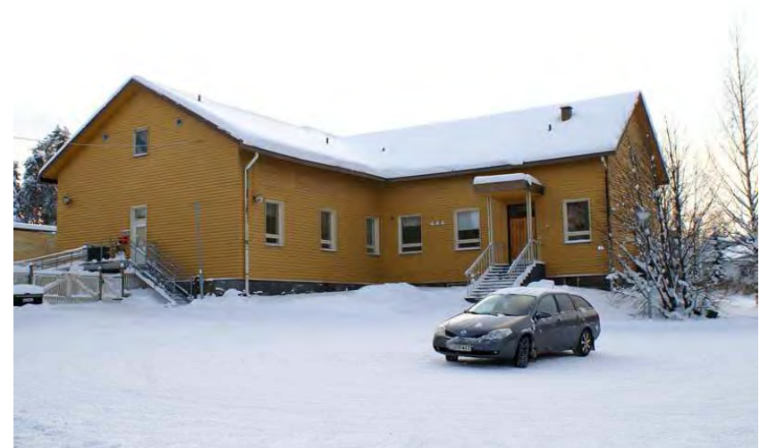
Kuva: A-rakennuksen koillispääty ja 1920-luvun siipiosa.
