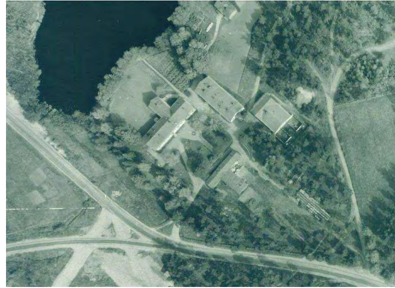
Kuva: Saattotie on rakenteilla. Ranta-alueet päärakennukselta saunalle ovat vielä peltotoini/niittyinä sekä hyötypuutarhana. A-rakennuksen edustalla on lipputanko ja hiekkakäytävien rajaamat nurmialueet puu- ja pensasisutuksin. / Ote ortokuvasta, 1960-luvun ap. / Mikkelin kaupunki.
