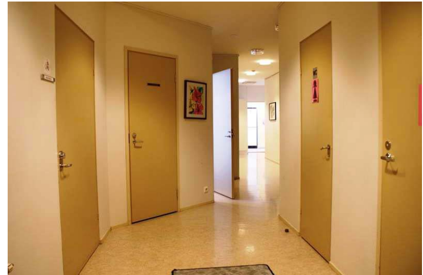
Kuva: A:n siipiosan käytävätila, tehty 1960- ja 90-luvun remonteissa.
